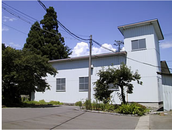
(排水処理施設)
