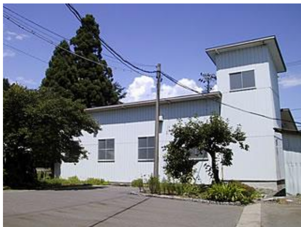
(排水処理施設)
